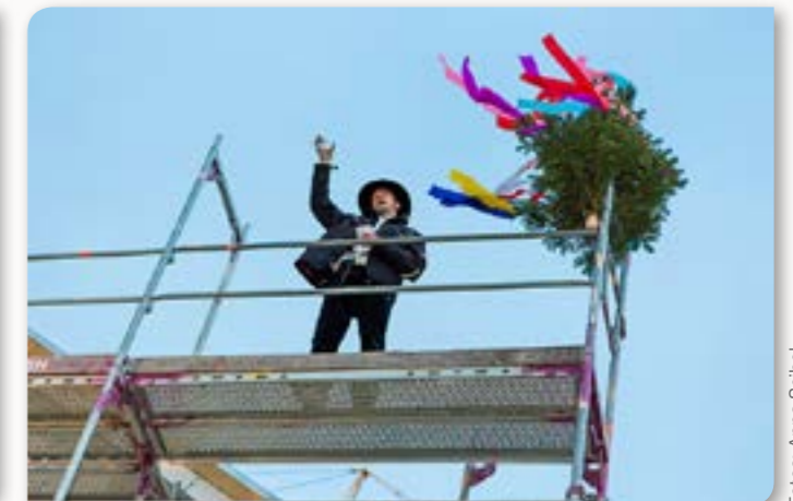
Der Zimmerer der Firma Albert Holzner beim Richtspruch.
