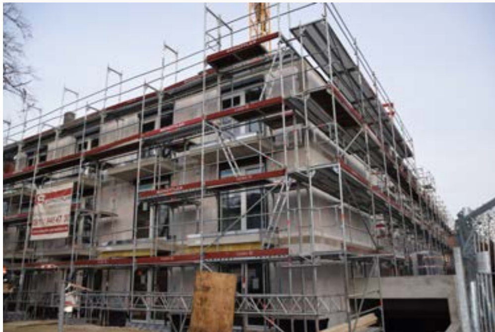
Der Rohbau steht, die Fertigstellung ist für Dezember 2019 geplant.
