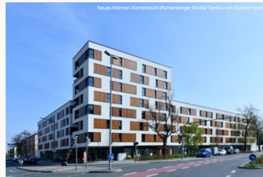
Neues Wohnen Sünderbühl (Rothenberger Straße/ Bertha-von-Suttner-Straße)
