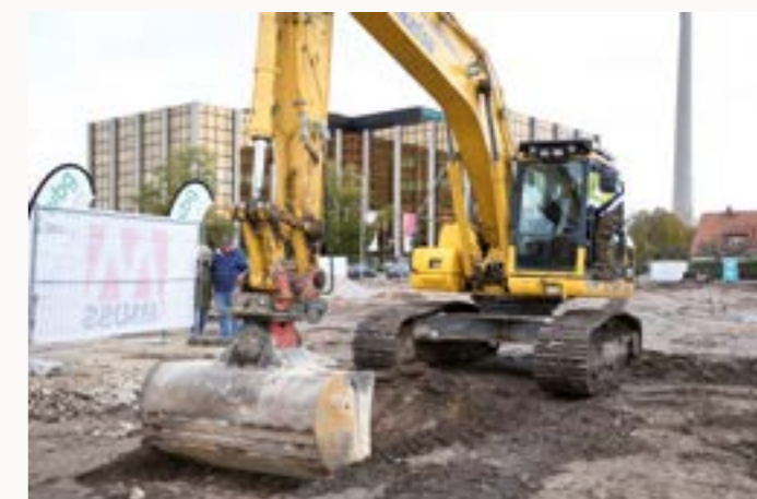
Mit Unterstützung von Baumaschinenführer Sebastian Lang führte Oberbürgermeister Ulrich Maly den ersten Baggerschub durch und gab damit grünes Licht für die künftigen Bauarbeiten
