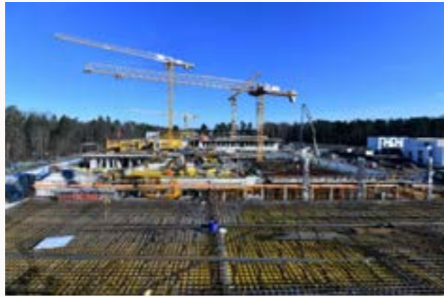
Der Blick über das Dach.
