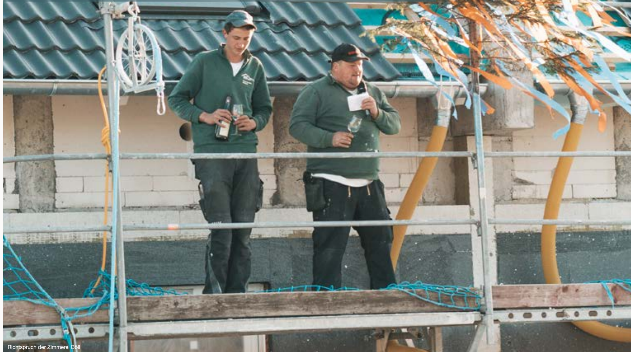
Richtspruch der Zimmerei Böll
