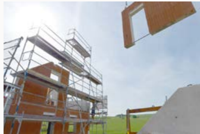
Komplette Wände und Decken für Häuser in ganz Süddeutschland entstehen im Rötzer Ziegelelement-Werk.
