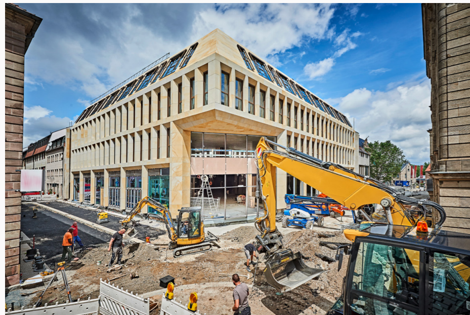
Aus der Vision wird Realität: Nach Abbau des Gerüsts wird die eindrucksvolle Fassade am Eingang Hallstraße erstmals sichtbar. Quelle: Mick Neuner
