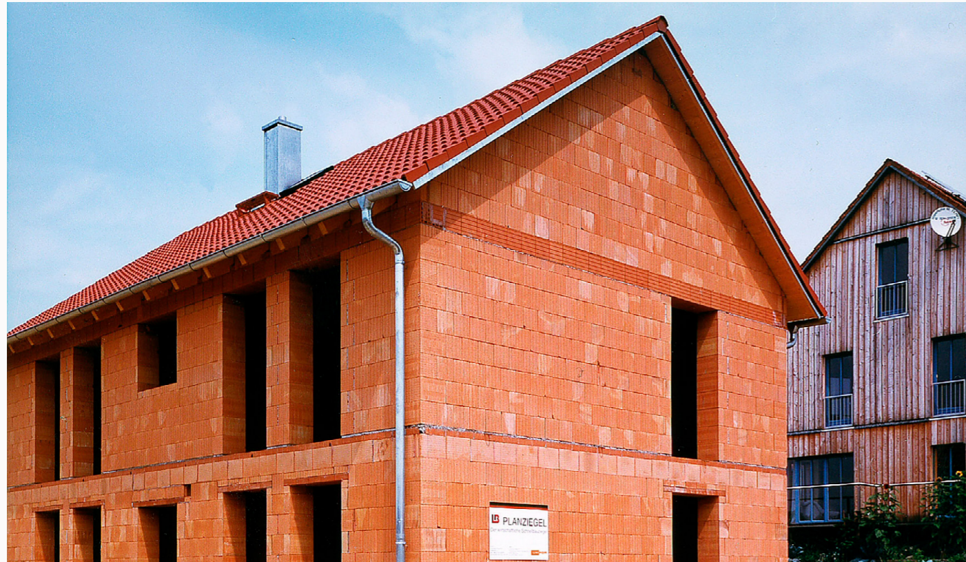
Bauliche Vorsorge ist besser als Nachsorge: Massives Mauerwerk aus mineralischen Ziegeln schützt Bewohner und Rettungskräfte im Fall eines Brandes. Viele Mauerziegel von Unipor trotzten den Flammen mindestens 90 Minuten. Foto: UNIPOR, München
