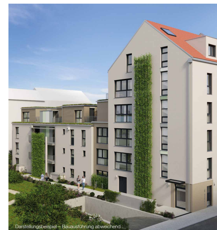
Darstellungsbeispiel – Bauausführung abweichend
