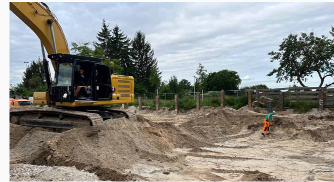
Baustelle, Grundschule Forchheimer Straße.
