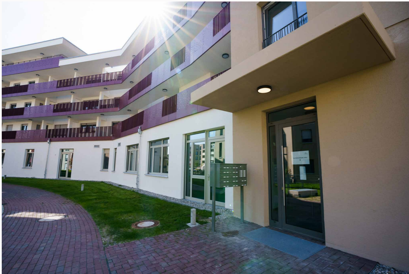
Geförderte Wohnungen hat die Schultheiß Projektentwicklung AG z.B. im Krügelpark errichtet
